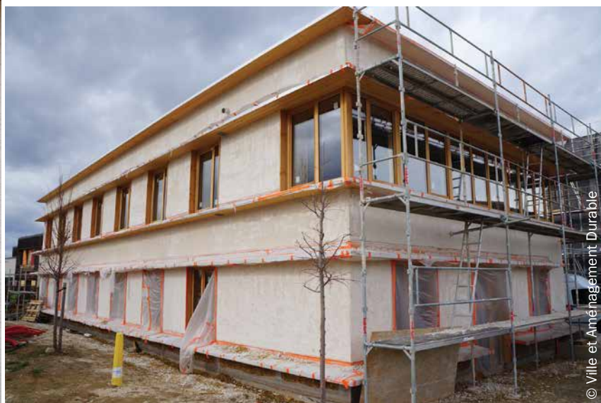
Des casquettes sur toute la longueur du bâtiment permettent d'éviter le ruissellement direct de l'eau de pluie sur la façade
