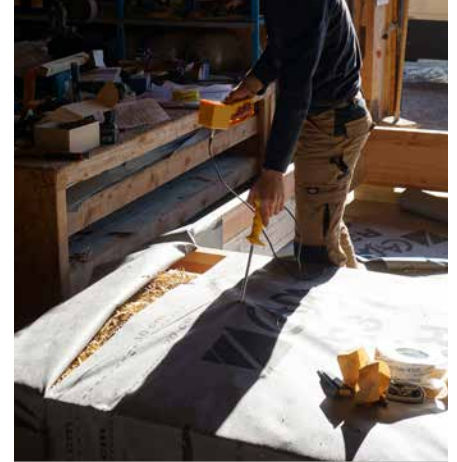
Contrôle de l'humidité de la paille du mur et pare-pluie temporaire
