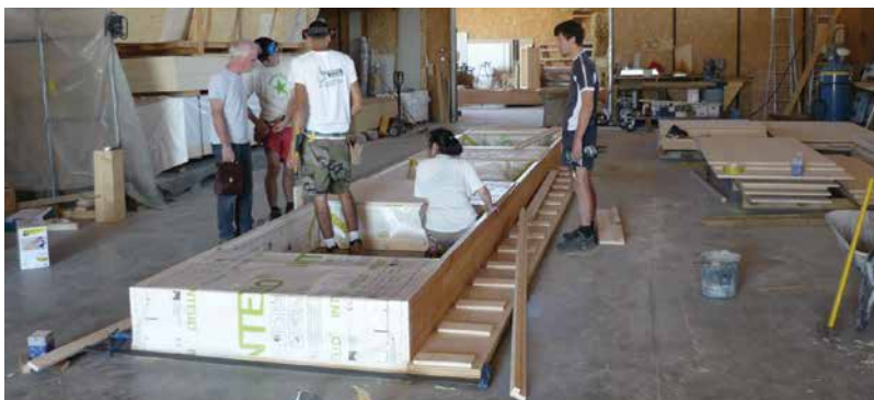
Atelier d'assemblage des murs caissons
